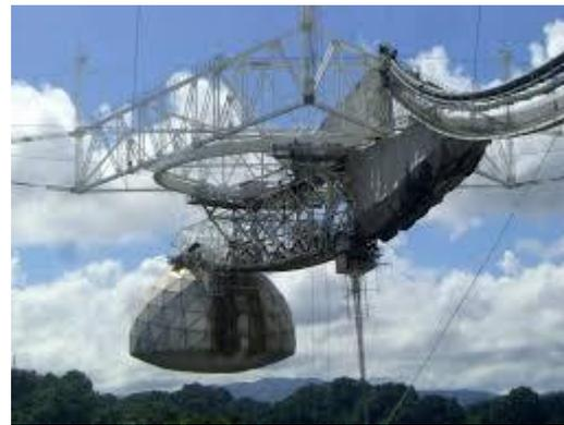
Le récepteur est situé sur une plateforme de 900 tonnes suspendue à 150 m au-dessus de l'antenne par 18 câbles
