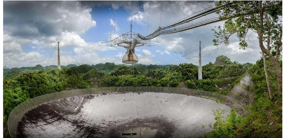
Antenne Sphérique de 305 m de diamètre. La surface de l'antenne est faite de 38 778 panneaux d'aluminium perforés, chacun mesurant environ 1 m sur 2 m, supportés par un maillage de câbles en acier
